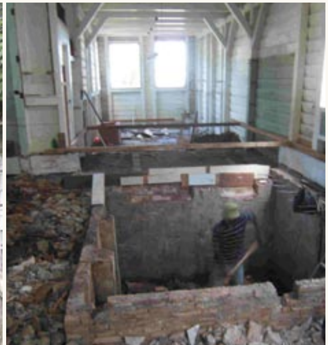
Waterkelder Henck Arronstraat 10 | Foto: S.Fokké/A.Lamur
